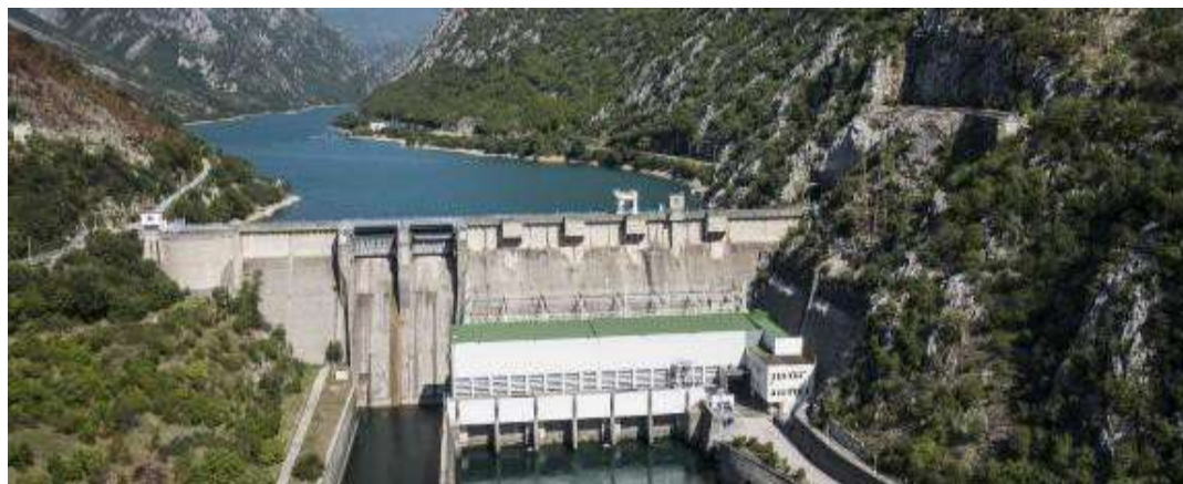
Slika 2-1. Pogled na nizvodno lice brane Salakovac
